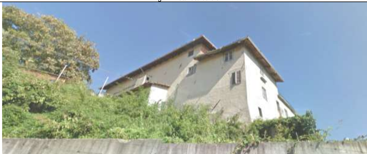
Fig. 5: Vista da sud - ovest
