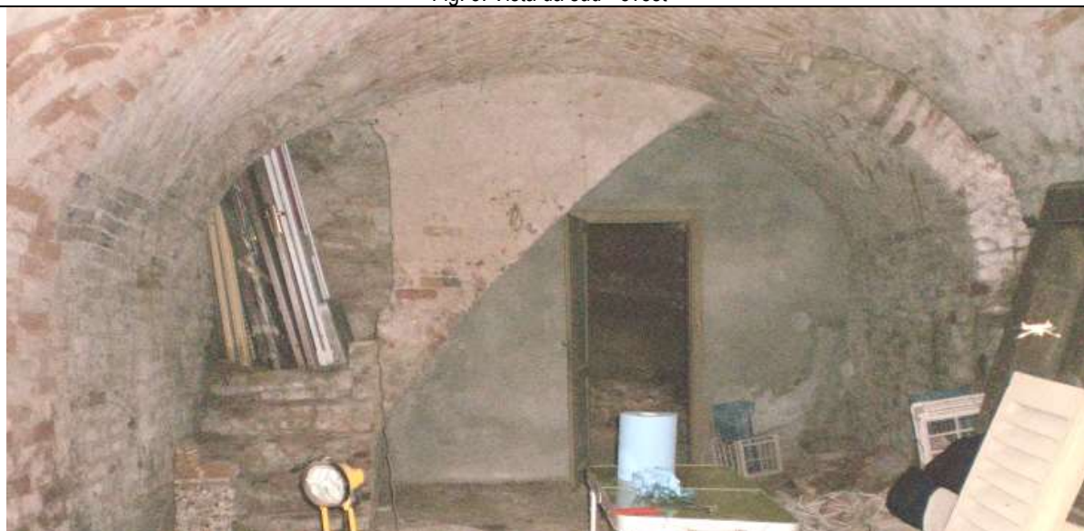
Fig. 6: Vista dei locali cantinati
