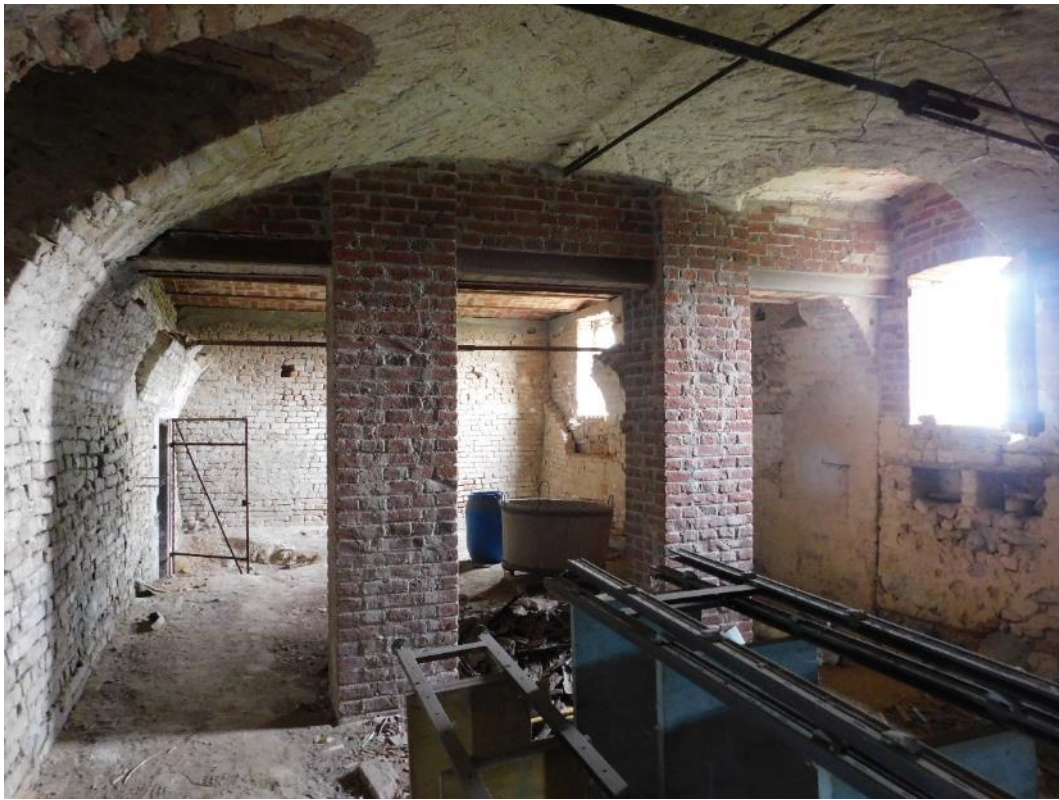
Fig. 2. Vista locale seminterrato
