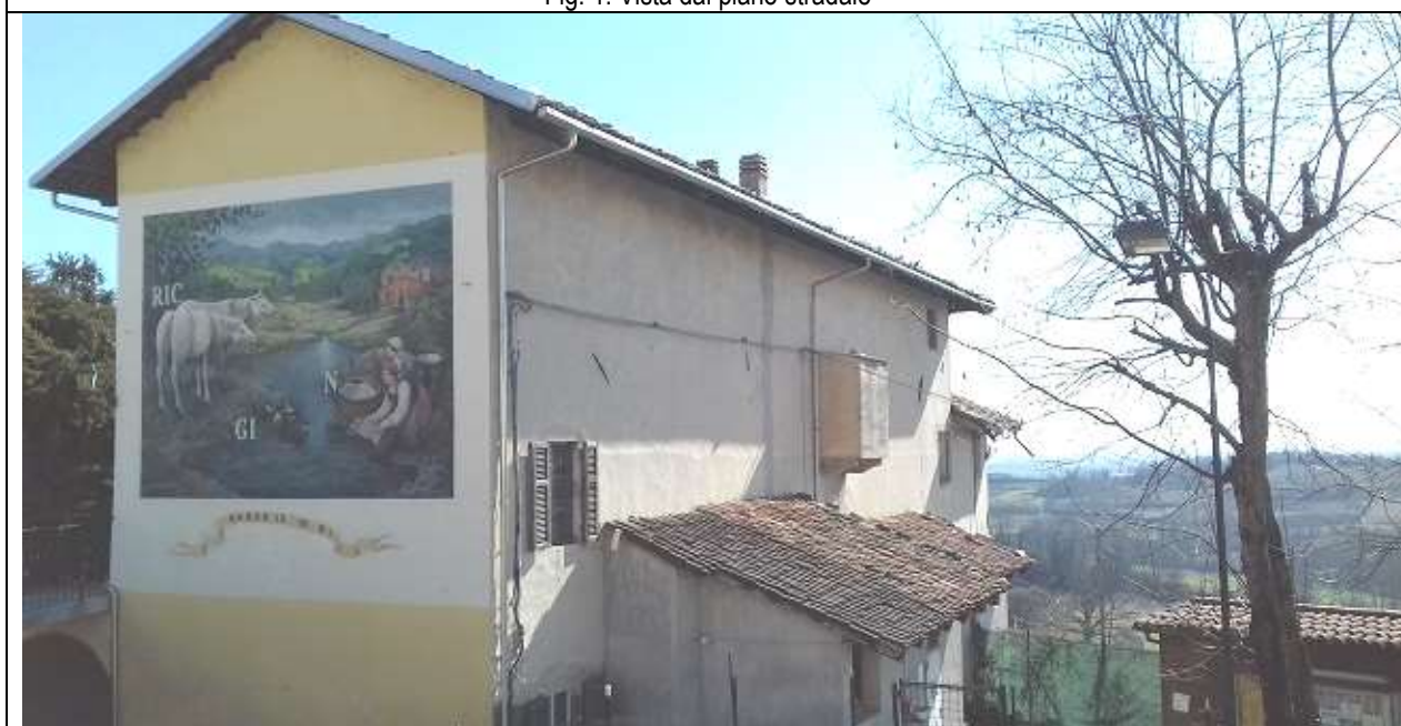
Fig. 2: Vista da nord - ovest
