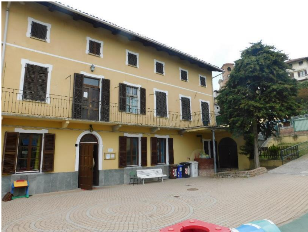
Fig. 1. Vista lato cortile, prospetto Est
