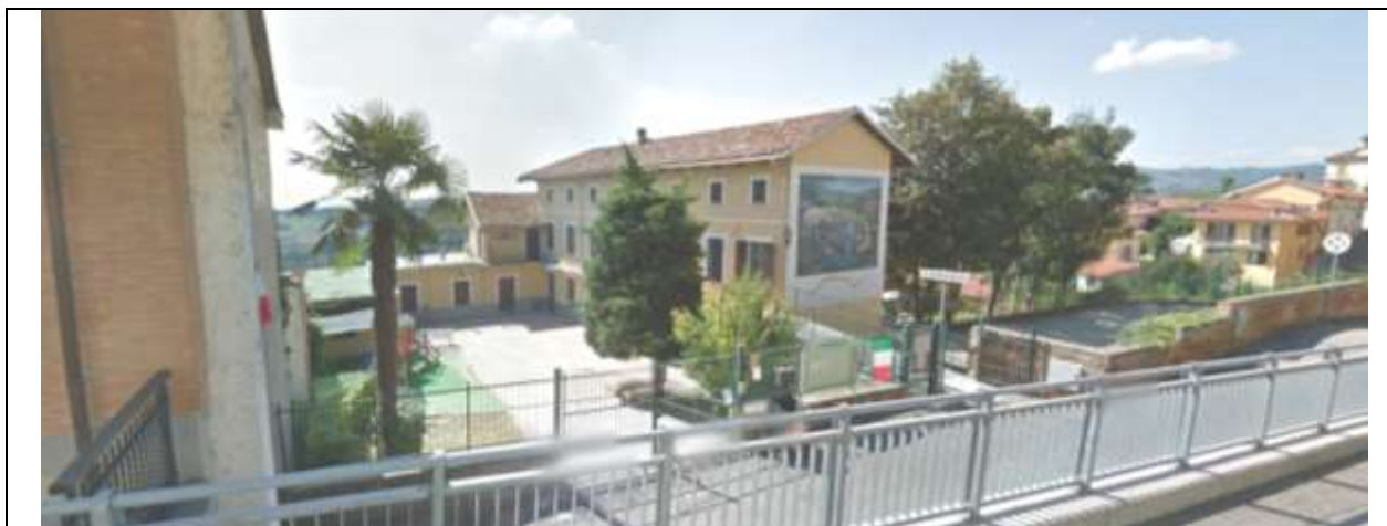
Fig. 1: Vista dal piano stradale
