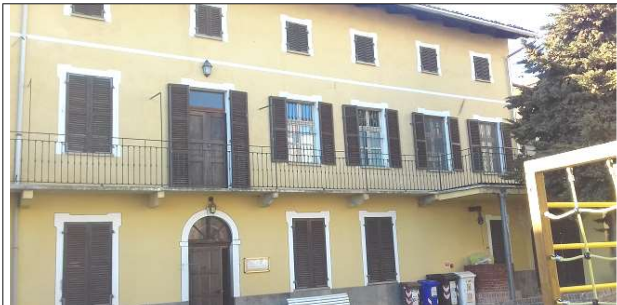
Fig. 4: Vista lato cortile
