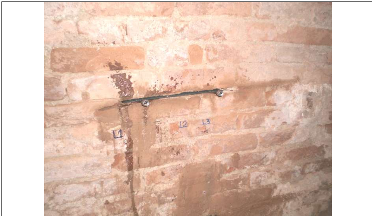
Fig. 7: Parete portante dove è stata eseguita la prova con i martinetti piatti doppi
